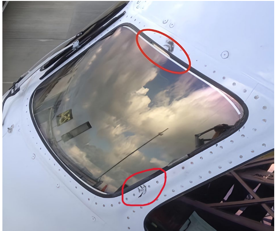
Punaiset ympyröidyt alueet ovat United Airlinesin Boeing 787 salamien vaurioittamia ikkunatiivisteitä. Kuva: NTSB.
